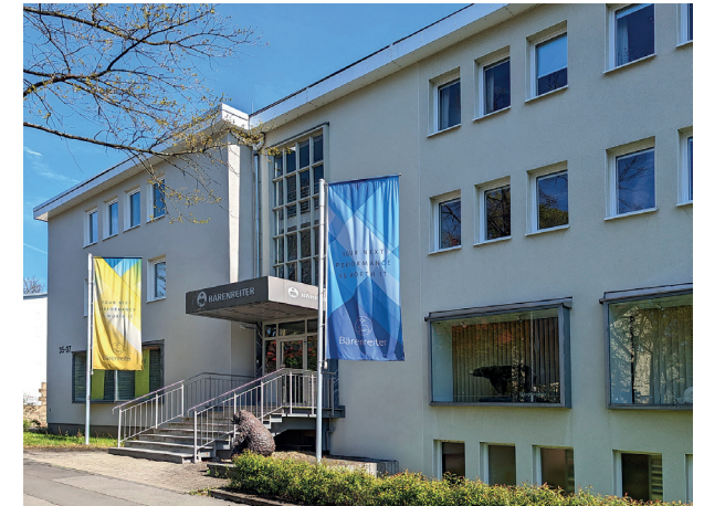
Das Verlagsgebäude in der Heinrich-Schütz-Allee in Kassel
